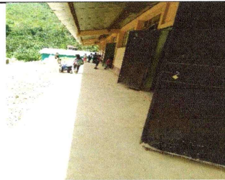
Foto 6: Sustitucion de Puerta de las aulas.
