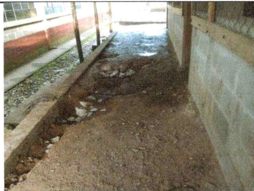
Foto 2: Reparacion de Piso de torta en el corredor de la cocina.
